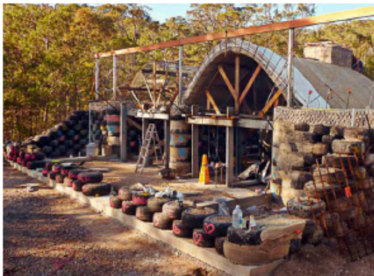
Fotoğraf 5. Earthship: İnşa aşaması [34]
