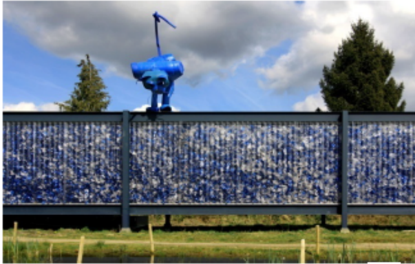
Fotoğraf 8. PET Pavilion: Genel görünüş [37]
